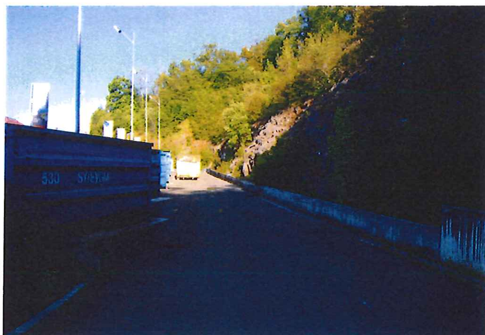
La déchetterie actuelle est bordée de talus rocheux et boisés qui ne facilitent pas l'extension sur place
